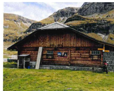
Auch die Alphütte Chäserugg ist auf IP umgerüstet.
